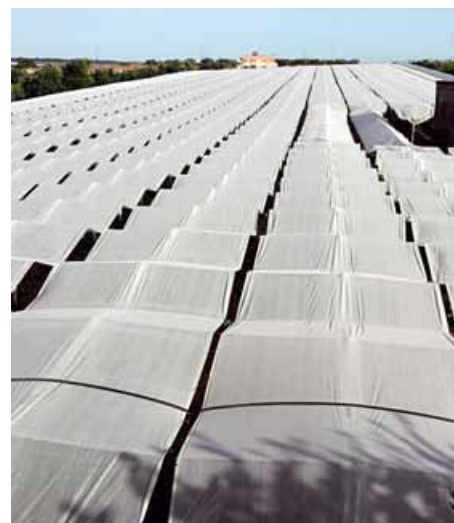
Foto 4 Sistema di copertura innovativo (Adelfia Puglia)
